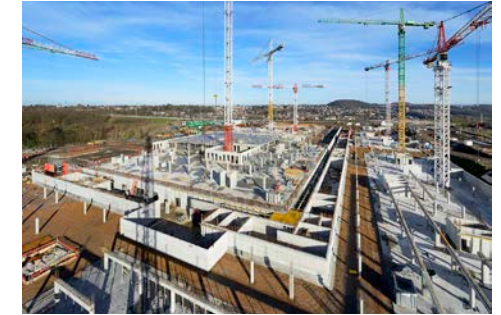
Hôpital Montégia [BE] - Arch. Assar et Artau architectures
